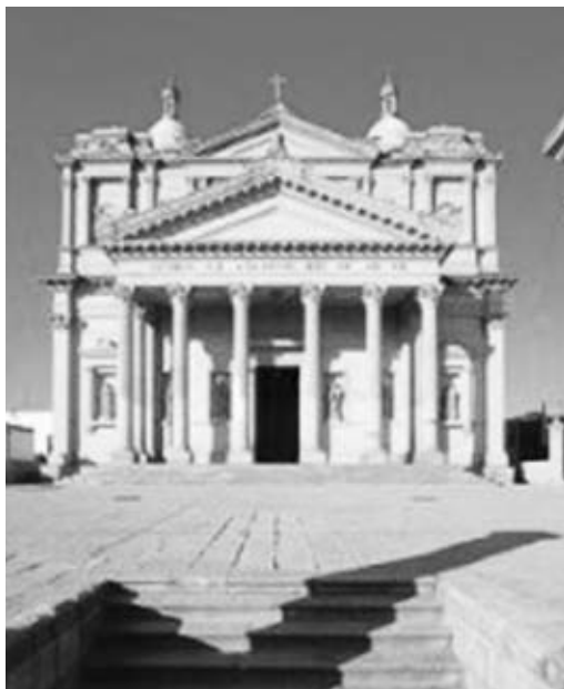
PARROQUIA DE SAN JOSÉ DE ITURBIDE. CONSTRUIDA POR EL REVERENDO PADRE NICOLÁS CAMPA Y RODRÍGUEZ. GUANAJUATO (1828-1890).
